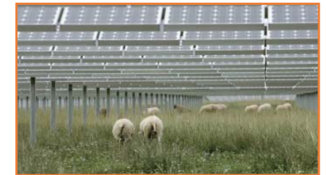
Granja solar de generación
